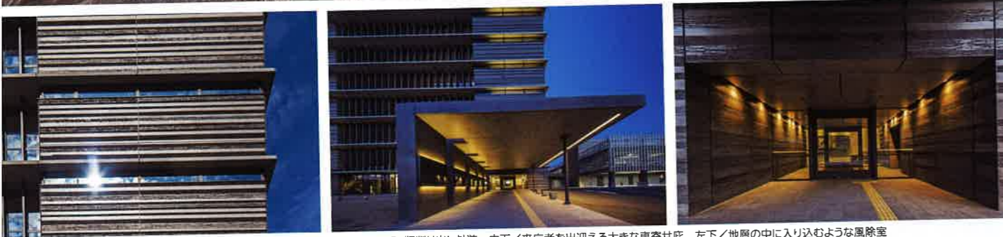
外装を内部に引き込んだエントランスホール 左下/ウォータージェットによるPCa版削り出し外装 中下/来庁者を出迎える大きな車寄せ庇 左下/地層の中に入り込むような風除室
