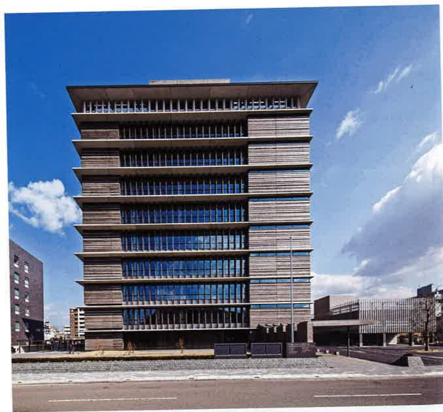
和歌山城に対して正面性を持たせた水平基調による端正なファサード
