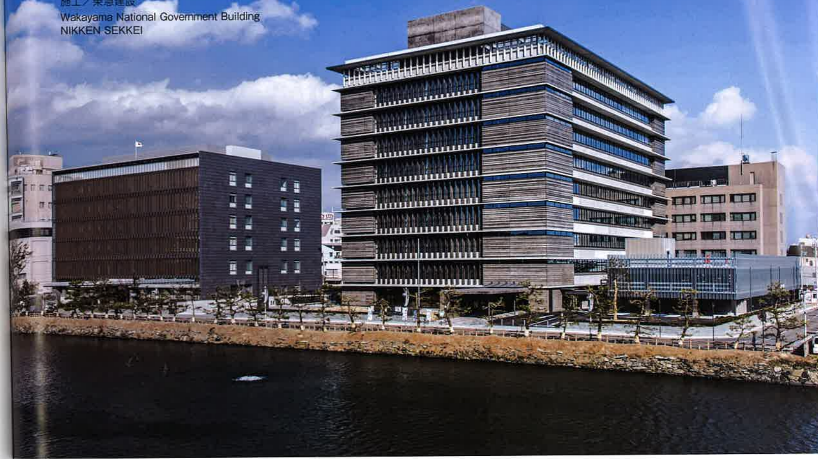
隣接する裁判所と外装デザインに共通性を持たせ、街区全体としての統一感を創出した
