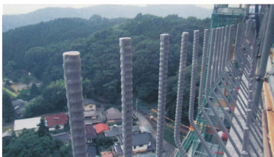
写真-3 壁高欄に配置された PVB-S 被覆鉄筋
