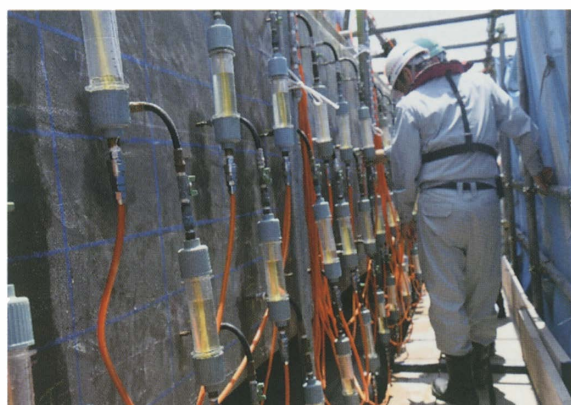
写真-2 簡易型亜硝酸リチウム内部圧入工法の施工状況
