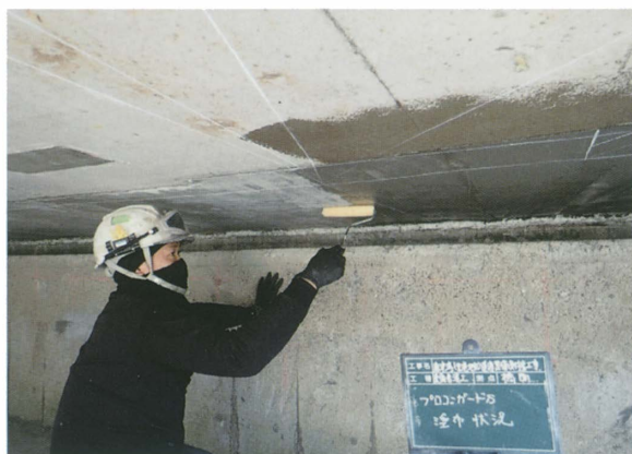
写真-1 亜硝酸リチウム併用型表面含浸工法の施工状況
