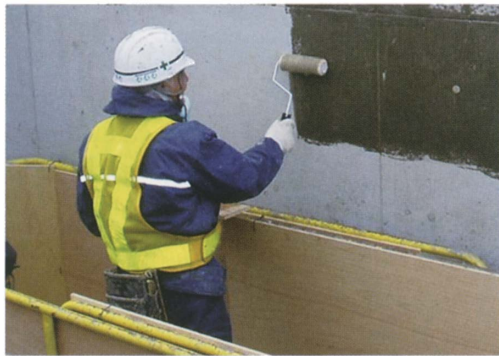
写真-2 シラン・シロキサン系表面含浸材 (MR) の施工例
