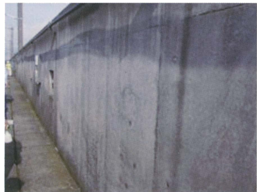
写真-5 凍害環境下の場所打ちコンクリート製の防音壁の外観
