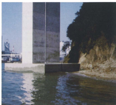
写真-4 塩害環境下における供試体設置箇所
