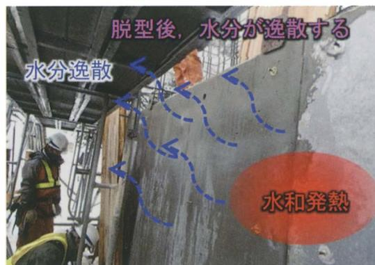
写真-3 実構造物に生じる水分の逸散状況
