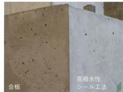
写真-2 高撥水性シール工法による表面気泡の減少
