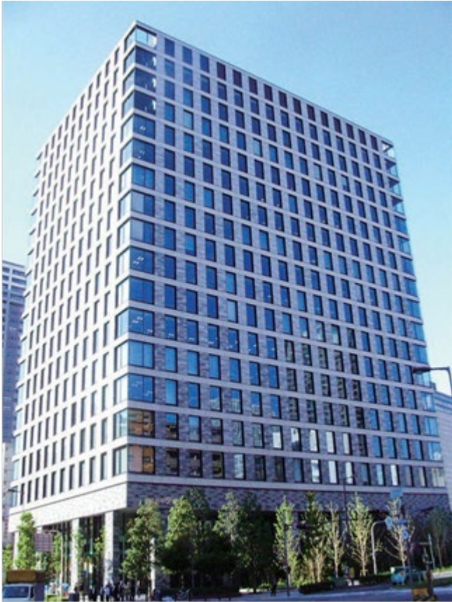
外墙 花岗石施工例 施工:2008 年/摄影:2010 年 OXC 涂层剂:OXC -330 （氟硅型防吸水剂）
