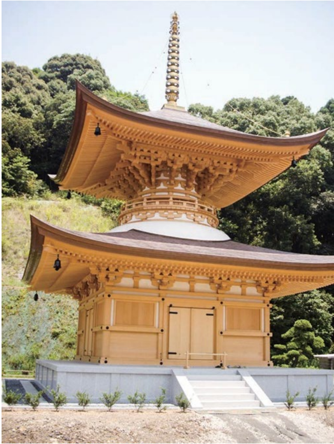
外部 根石处施工例 施工:2009 年/摄影:2010 年 OXC 涂层剂:OXC-341 （硅系渗透性防吸水剂）
