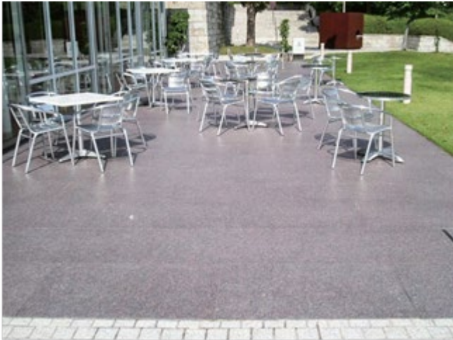
外部地面 花岗石例 施工:2002 年/摄影:2007 年 OXC 涂层剂:OXC-341 （硅系渗透性防吸水剂） OXC -345 AB （高聚合氟聚合物树脂防污剂）
