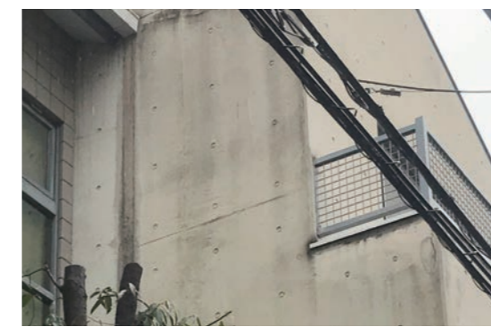
RC面 打ち放し意匠FFP工法 1000㎡
