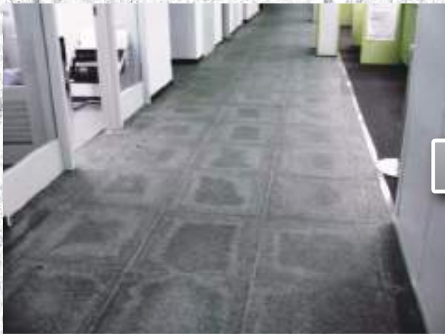
漏水による汚染
