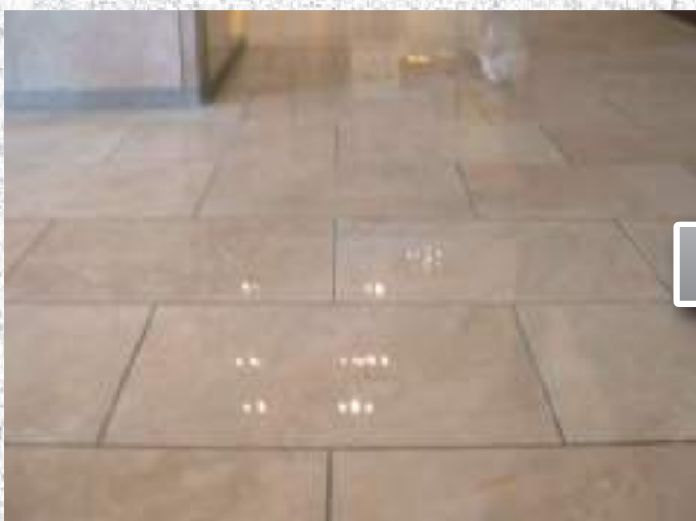
③OSHIROXコート施工 研磨乾燥後
