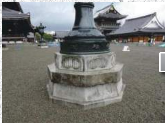
汚染・施工前
