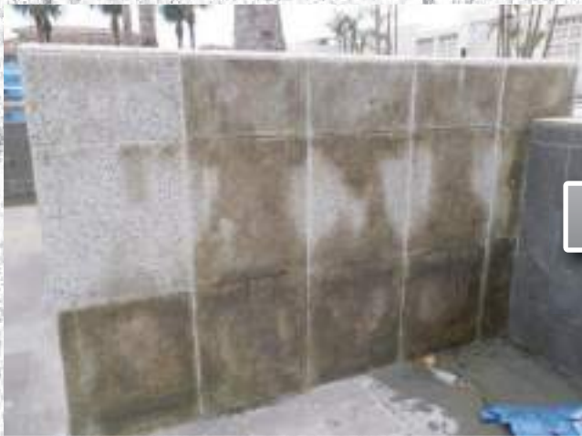
裏面コンクリート灰汁によるアルカリ黄変
