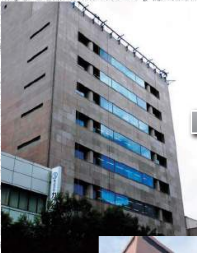
2017年8月東面 施工前
