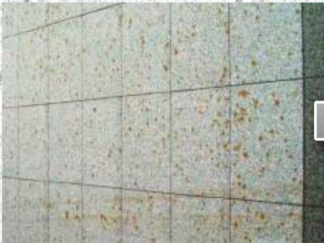
石材鋳物による錆汚染施工前
