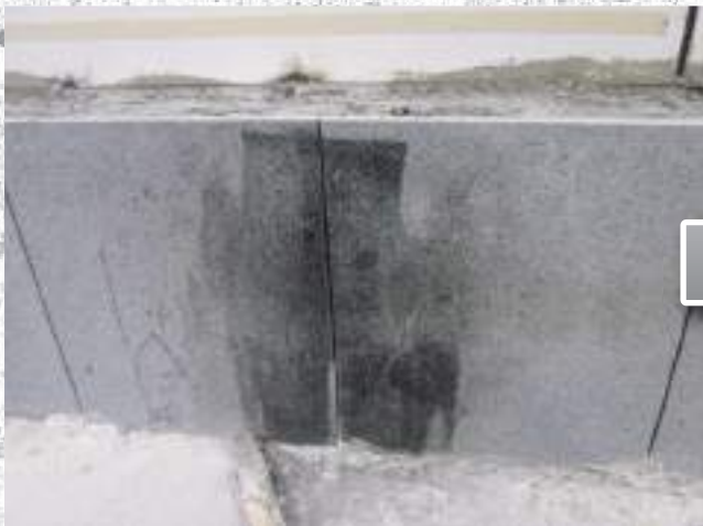
建設機械油飛散による重油汚染
