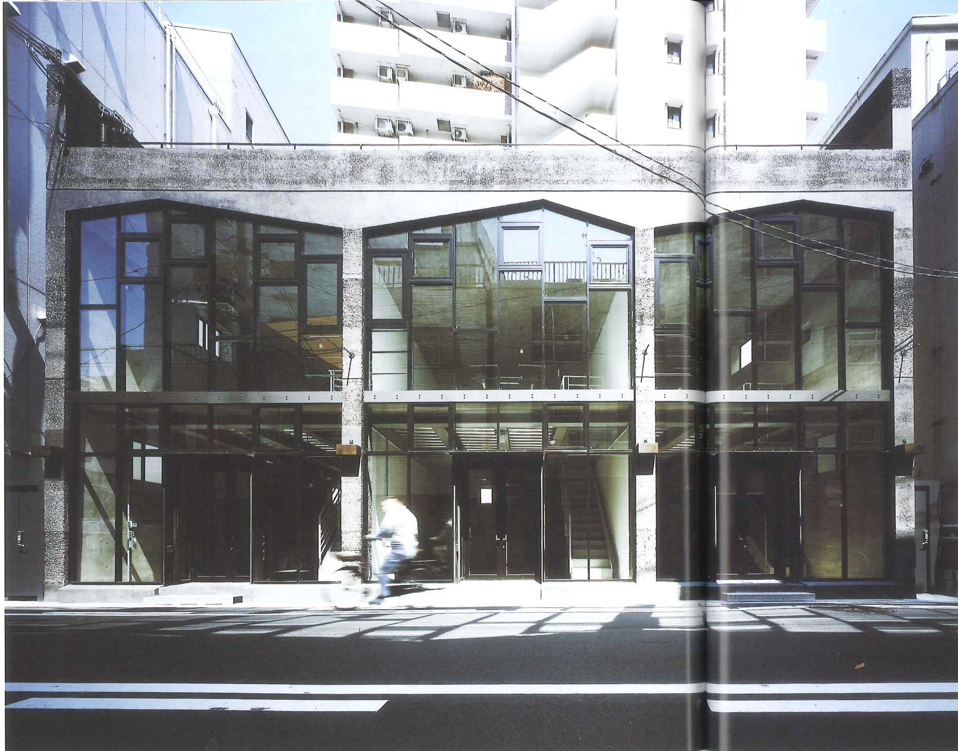
左／日本一長い商店街、大阪・天神橋筋近くに立つテナントビル「ナガヤ200」。敷地周辺のコンテクストを引き継いだ2階建ての低層建築 右／前面道路側を全面開口として近隣に開きつつ、耐火や構造を担うそれ以外の3面は土地の歴史を感じさせる地層のような表情のコンクリート壁とした。外壁を上には伸ばして設置し、将来増築が必要になった際に手掛かりとなることを意図している
