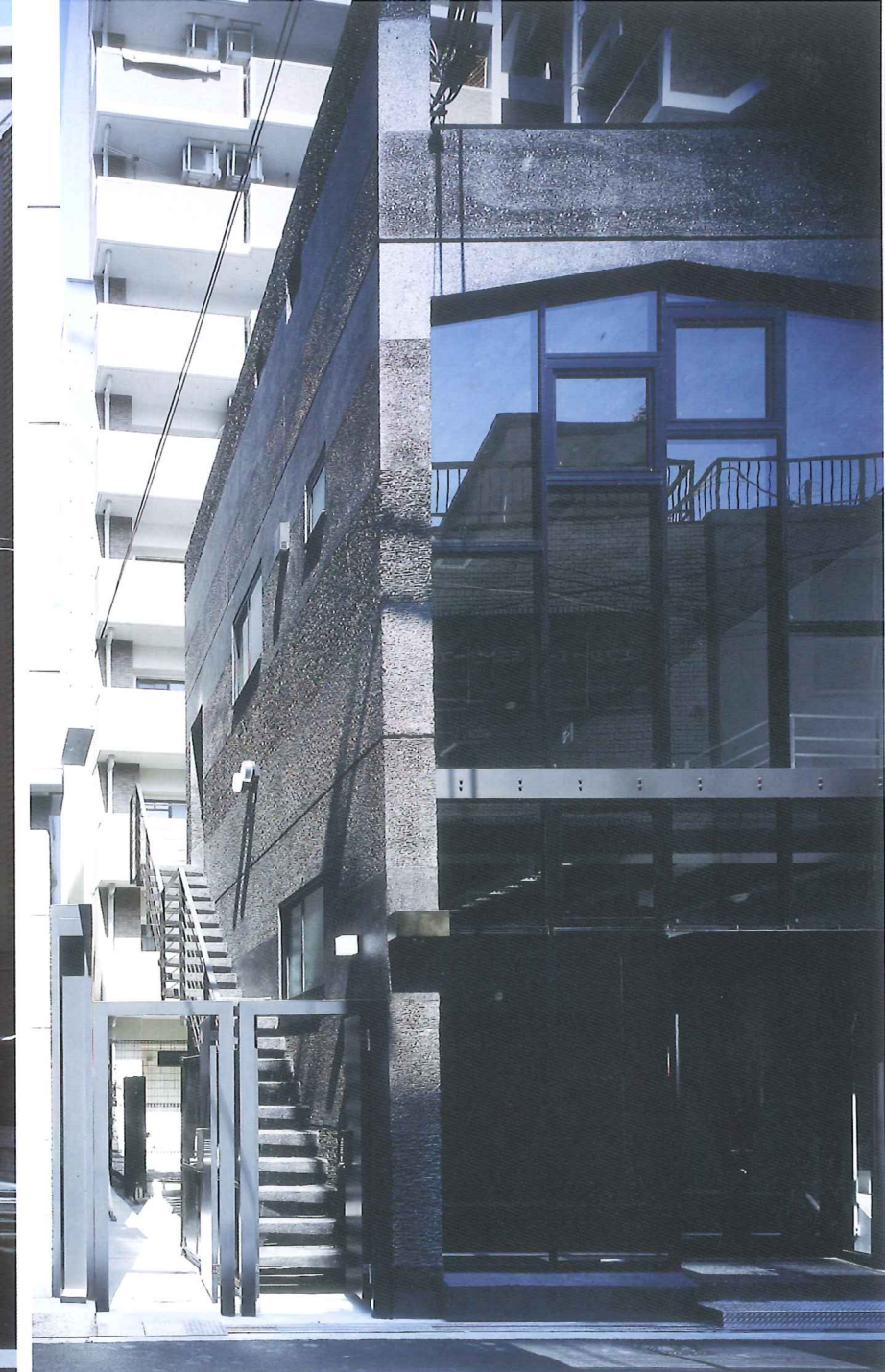
左／日本一長い商店街、大阪・天神橋筋近くに立つテナントビル「ナガヤ200」。敷地周辺のコンテクストを引き継いだ2階建ての低層建築 右／前面道路側を全面開口として近隣に開きつつ、耐火や構造を担うそれ以外の3面は土地の歴史を感じさせる地層のような表情のコンクリート壁とした。外壁を上には伸ばして設置し、将来増築が必要になった際に手掛かりとなることを意図している
