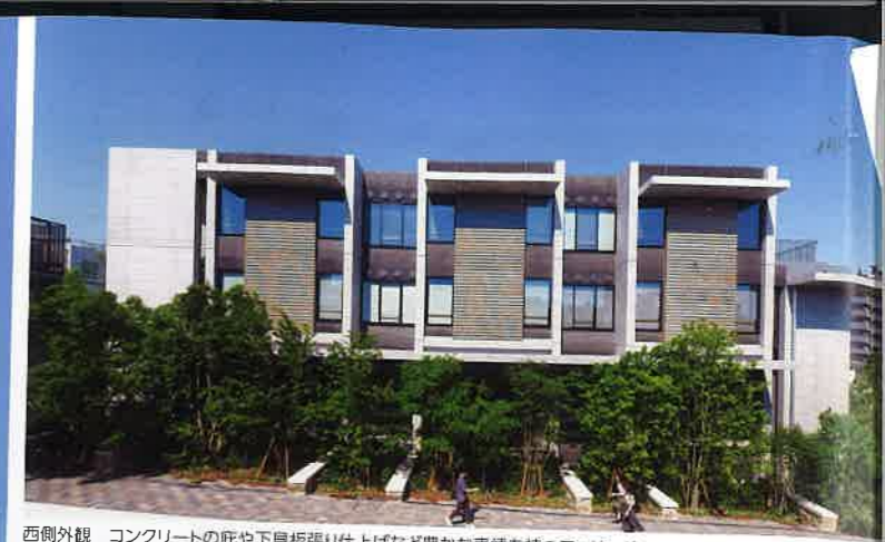
西側外観 コンクリートの庇や下見板張り仕上げなど豊かな表情を持つファサード
