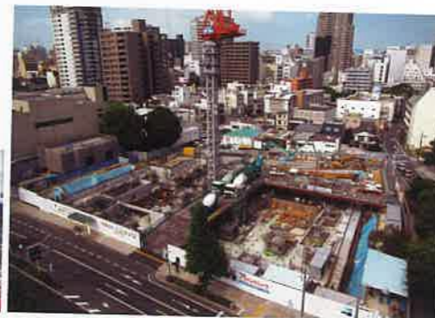
地下躯体施工状況
