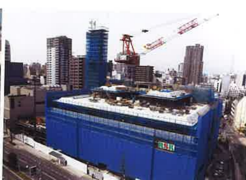
地上施工状況
