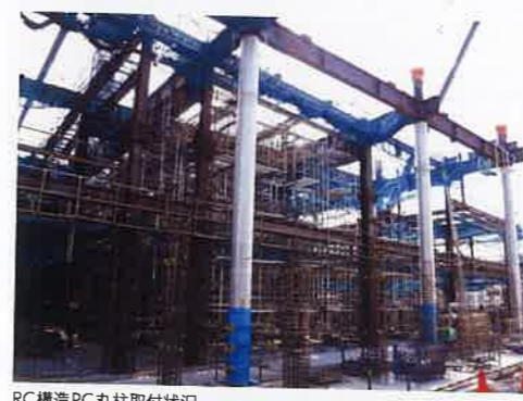
RC構造PC丸柱取付状況
