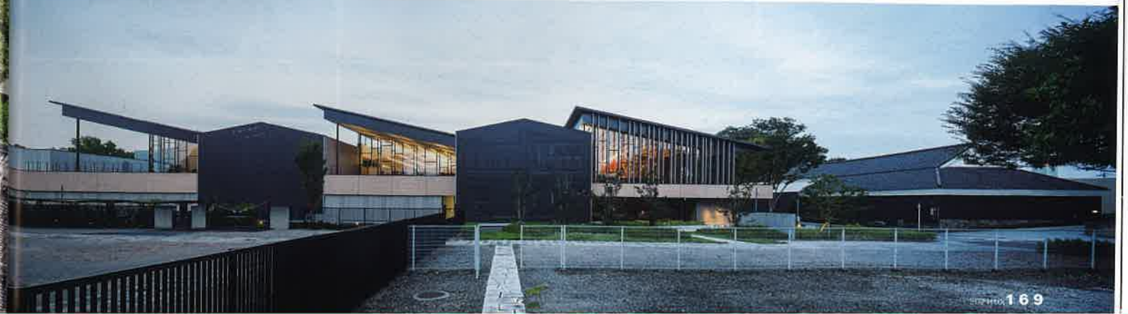
西側夕景。南側に隣接する蔵との連続性を考慮した、低く抑えたボリューム。
