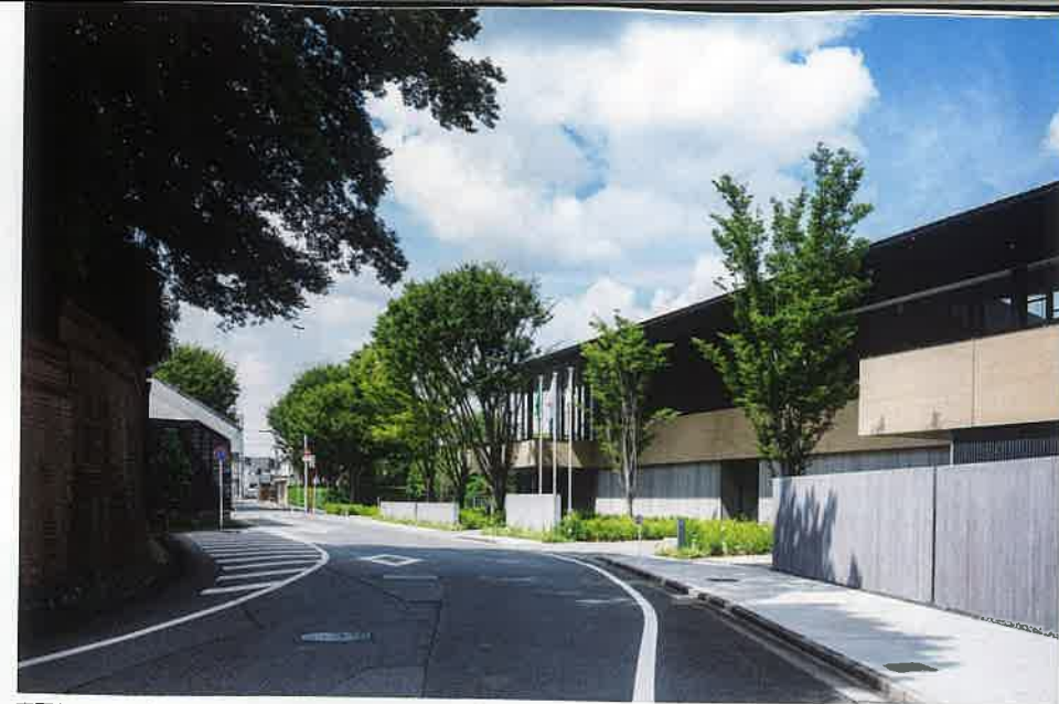
南面を見る。蔵や神社のスケールや塀のある風景を踏襲している。
