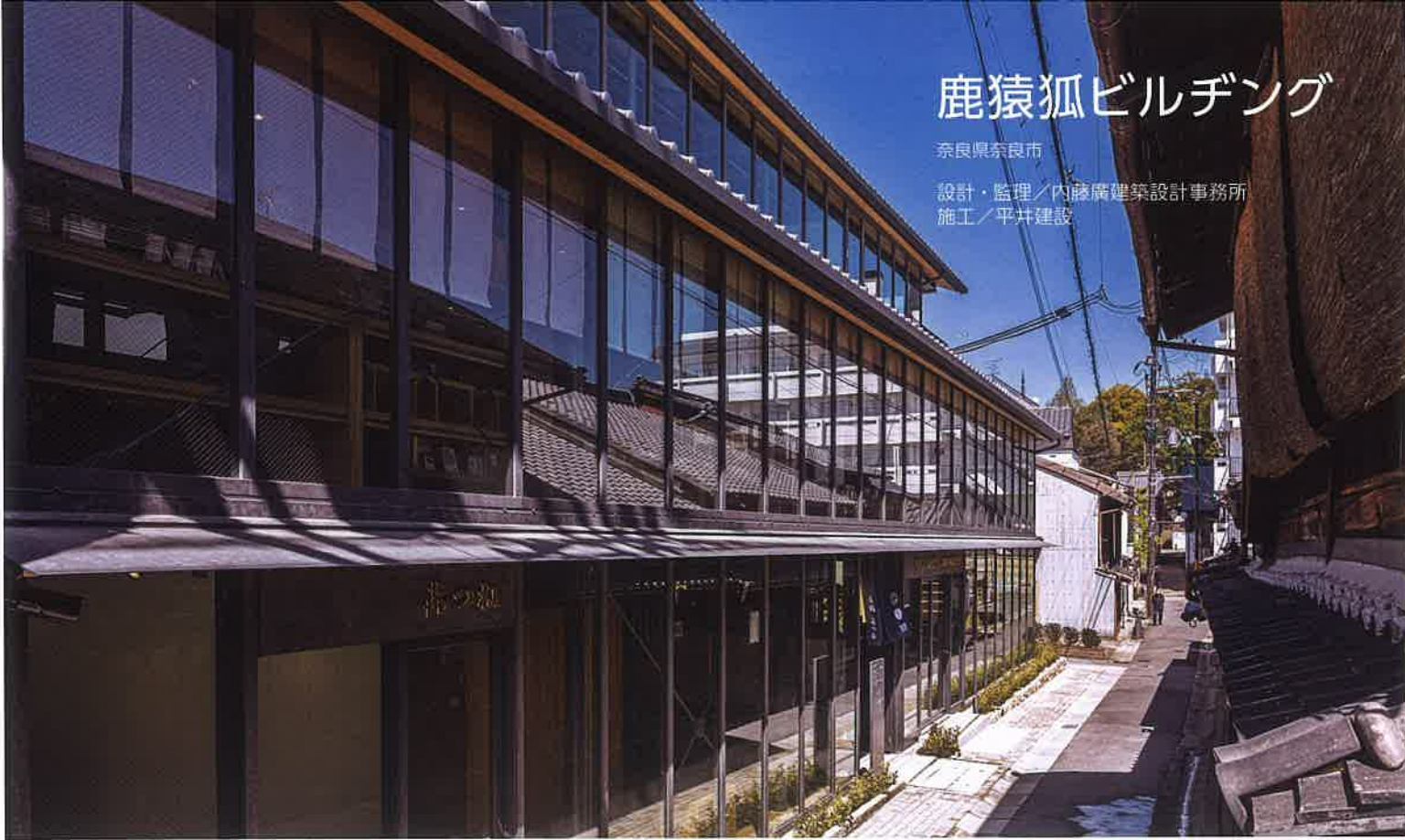
建物外観 透明感のあるガラスのカーテンウォール
