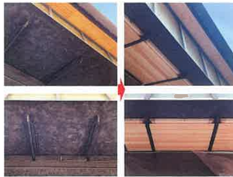
金属庇取付工事(左:軒天取付前・右:軒天取付中)
