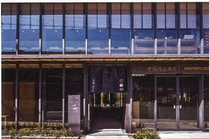
東側立面 2つの店舗の間を通り抜けて坪庭へ出る
