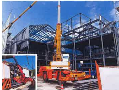
鉄骨工事(建方状況)
