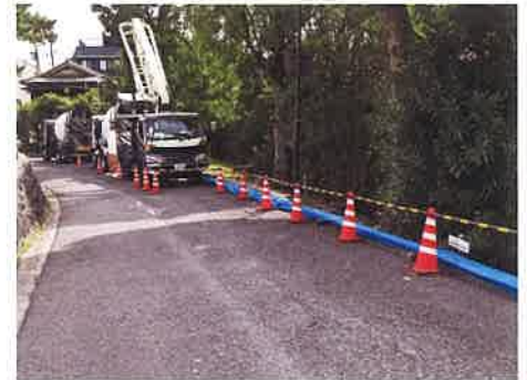
コンクリート工事(配管打設状況)
