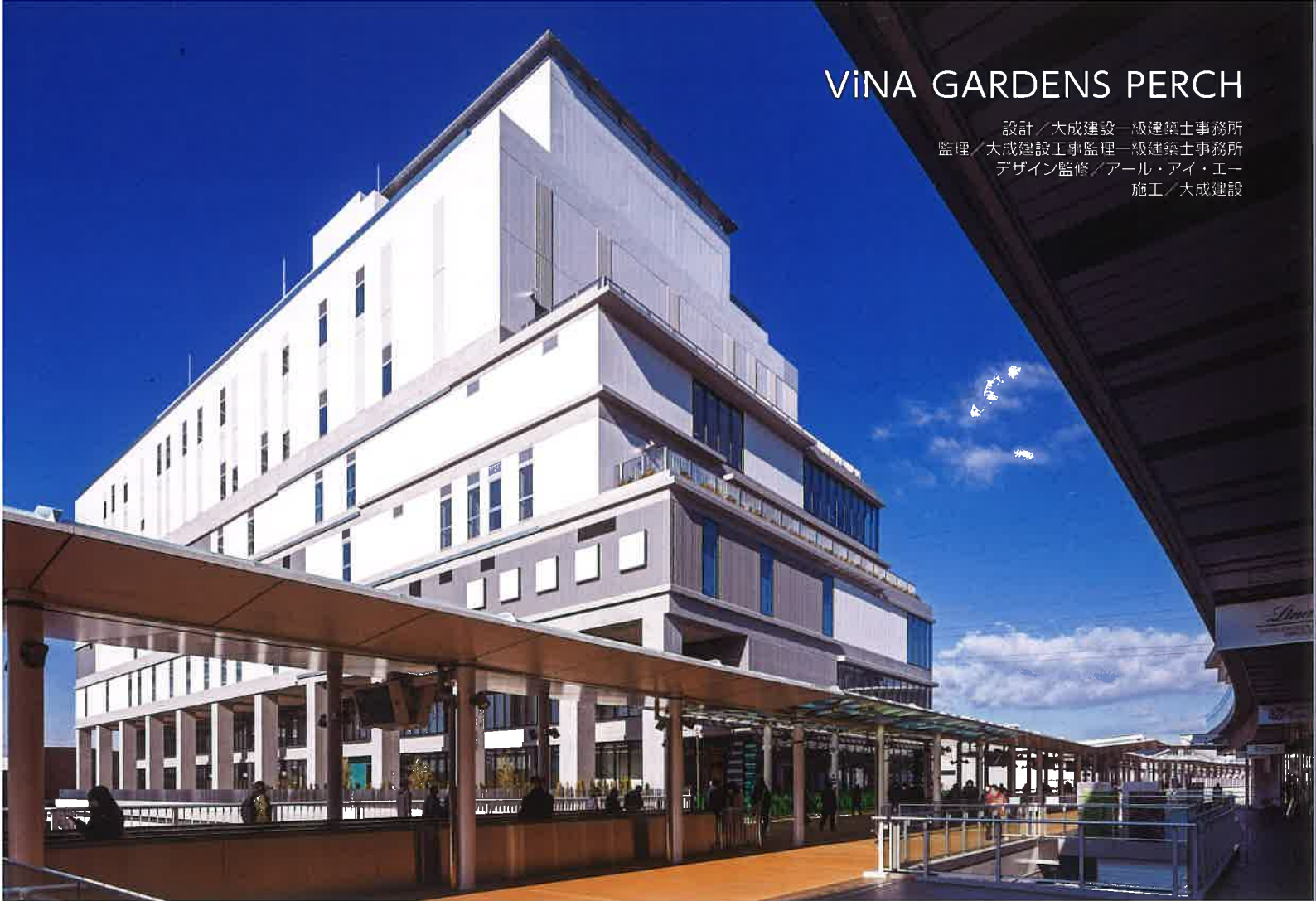
上 / 南東側外観 自由通路から見る
