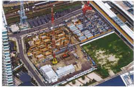
写真提供/大成建設
