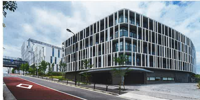
南東側外観。ルーバーはプライバシーの確保・採光によって4面の疎密を調整している。
