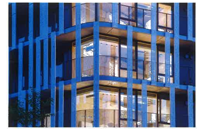
南東側夕景。外周に面する寮室と周辺環境とのプライバシー確保・西日対策・共用空間の開放性など内外の条件変化を穴あきルーバーパネルの疎密のグラデーションに置換した環境制御ルーバーを有するファサードとした。
