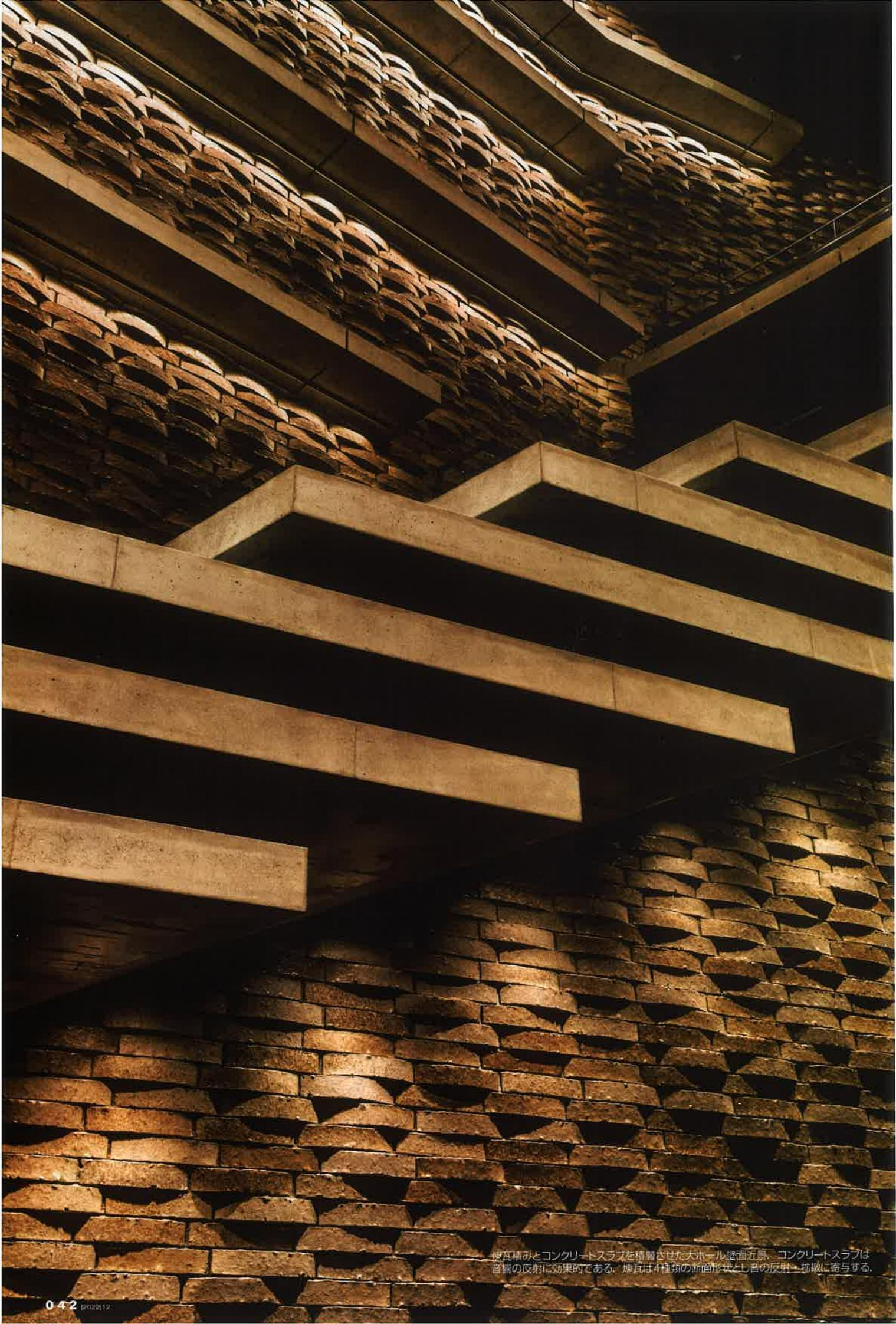
煉瓦積みとコンクリートスラブを積層させた大ホール壁面近景。コンクリートスラブは音響の反射に効果的である。煉瓦は4種類の断面形状と七音の反射に寄与する。
