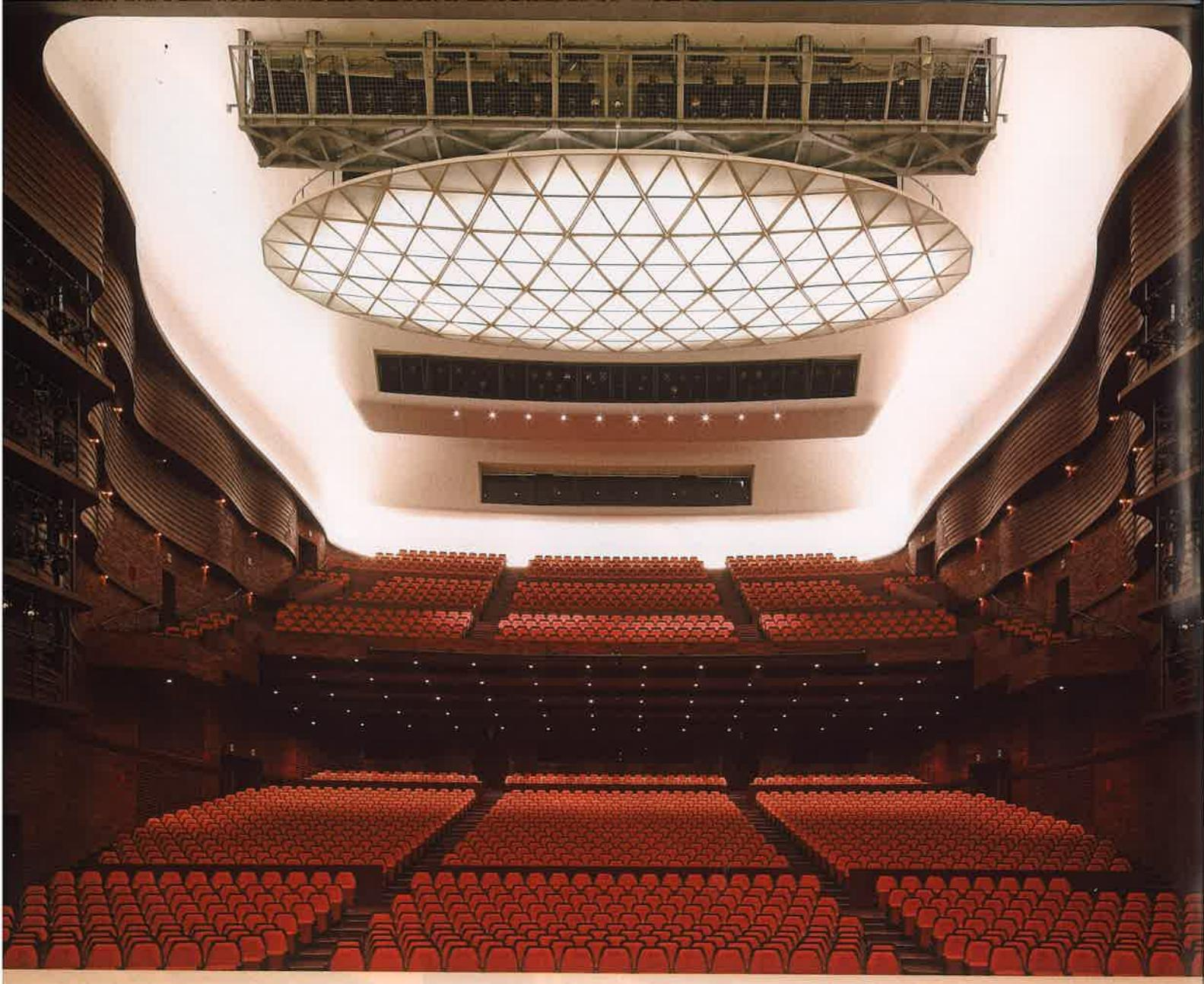
大ホール、天井の浮雲に舞台照明、舞台音響スピーカー、残響可変カーテンを設置し、音響拡散や光演出の役割を持つ。壁面に秋田スギの木煉瓦を使用。
