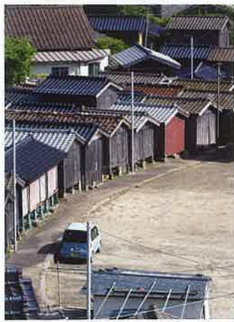
小屋(コヤ)。家財道具等を保管する高床の板倉。母屋から離れて群倉立地する。*
