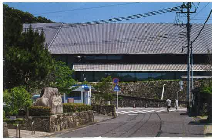
南より見る。軒先を極力石垣に近づけることで決定。最高高8,616mm～軒先3,746mm。
