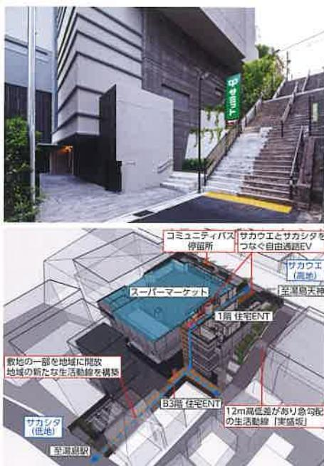
左ノ/地域の誰でも使える自由通路エレベーター 右上ノ/低層部の分節化とハイブリットピーリング工法等を採用した素材感ある仕上げにより、圧迫感の低減と景観との調和を図る 右下ノ/サカウエとサカシタをつなぐ、半公共空間として開放した敷地・建物の利用プログラム
