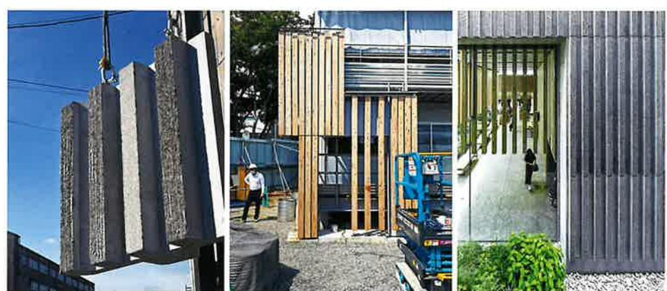
左2点／サンプル、モックアップを作成し、素材の仕上がりや取り付け方法などを現場で確認した 右／凸部はウォータージェット縦目仕上げし、木の表情との調和を図った
