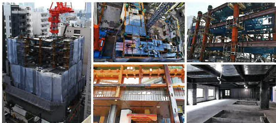
左／フロアクライミング工法 中上／先工区と後工区に分けての施工 中下／古民家再生木材を使用した吹抜スペース 右上／鉄骨建方状況
