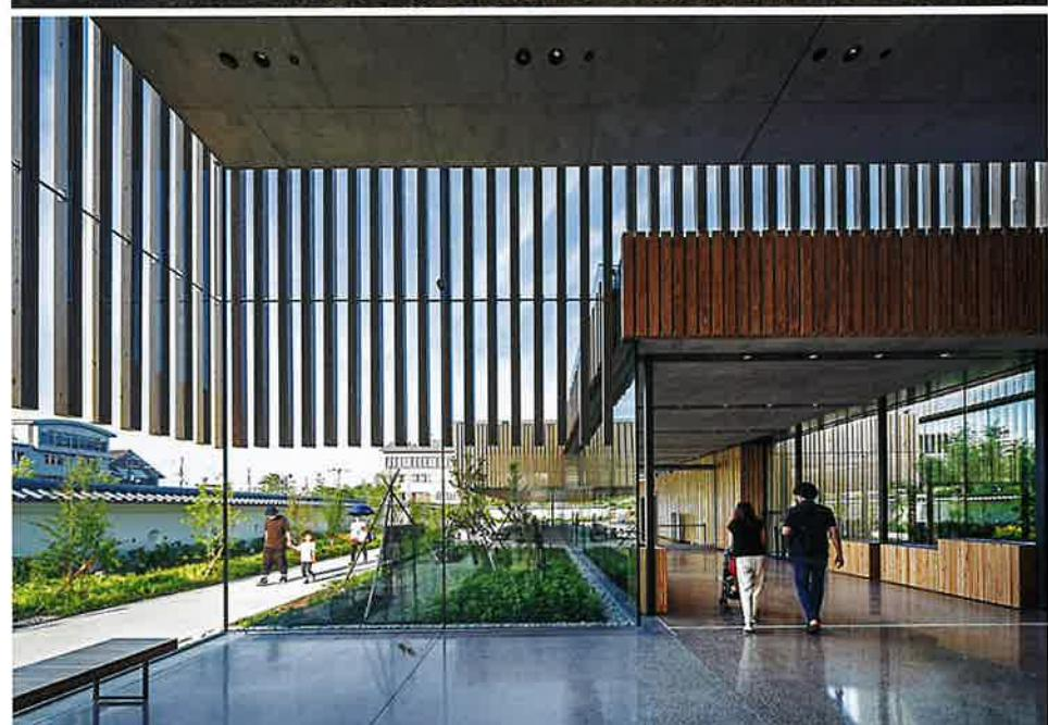
上／13.5m×21.6mの無柱エントランス空間と4.4mの片持ち軒庇。プレキャストコンクリート版の大屋根の鉛直荷重を支える柱は、軽快さを表現するため無垢の鋼材を採用し、100角の極細柱を実現 下／外部と内部の木製ルーバーが連続する緑と光があふれる開放的大ホールホワイエ。空間を散策していると随所に光と緑を体感できるように、建物各所には中庭や屋上緑化の木々を配置した
