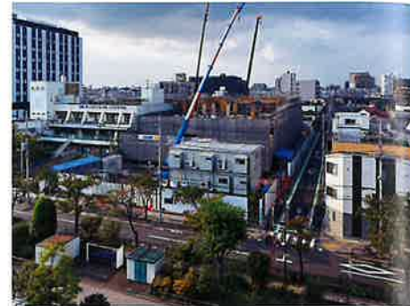
躯体工事状況
