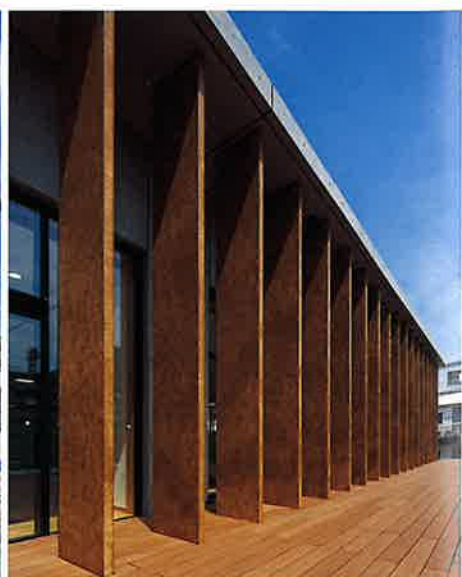
2階デッキルーバー
