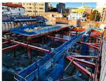
地下工事中現場全景
