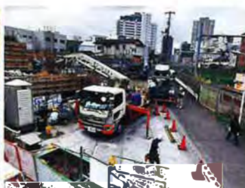
コンクリート打設時ポンプ車生コン車両配置
