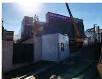
揚重作業時クレーン車配置
