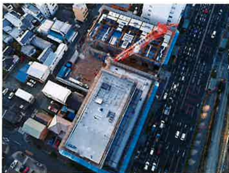
本店棟と本部棟の2棟同時施工
