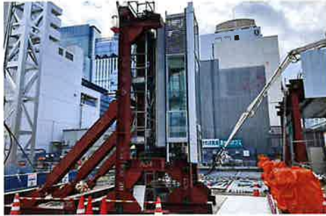
外装カーテンウォールのモックアップ
