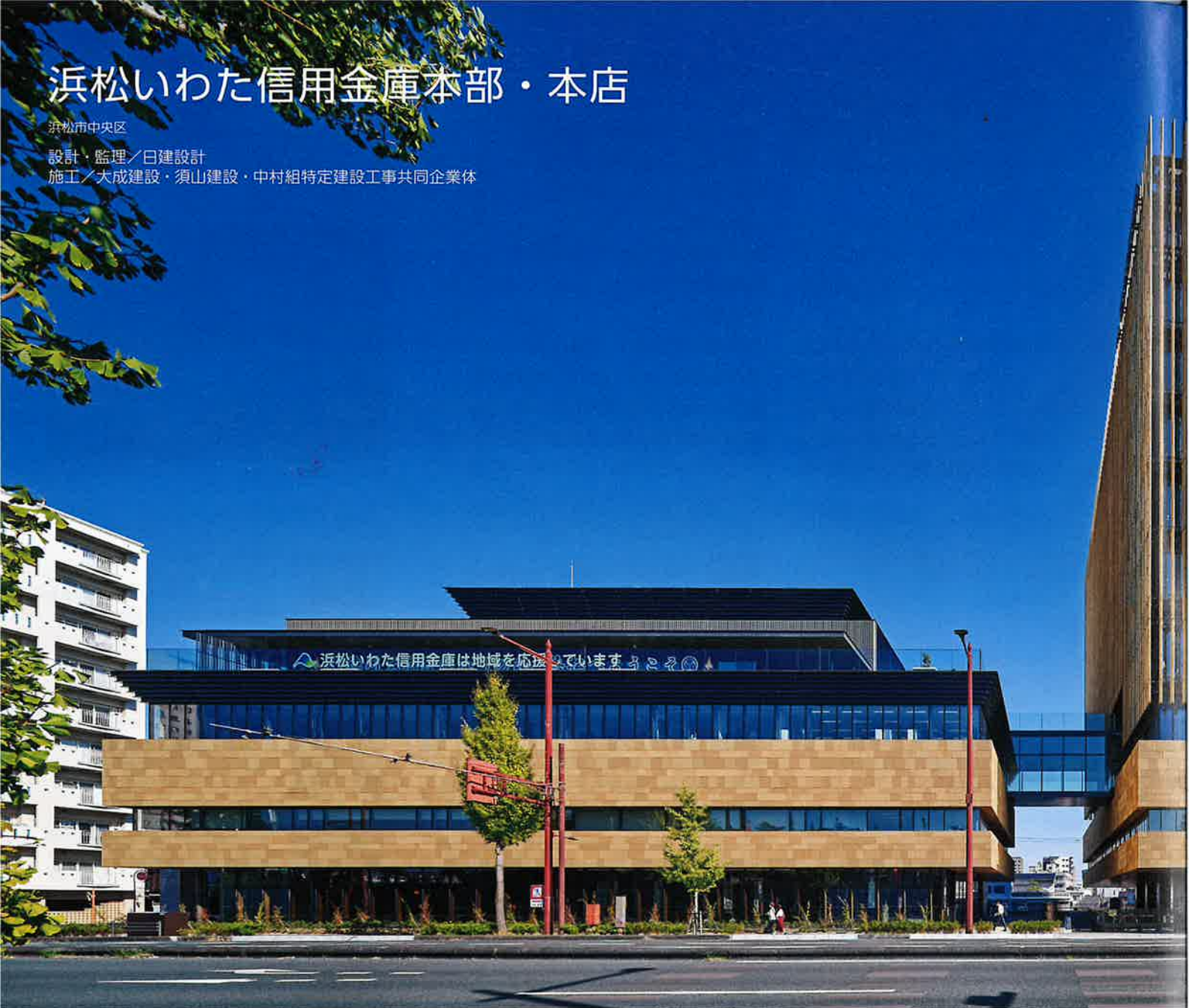
光の移ろいを捉え、刻々と表情が変化するグラデーショナルに角度が変化するテラコッタルーバーで構成された外装
