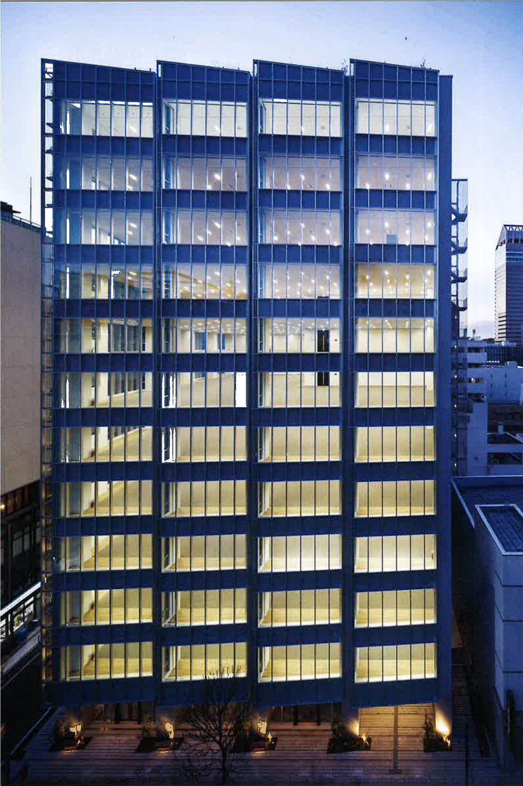
北面ファサード アルミカーテンウォールがズレながら重なる
