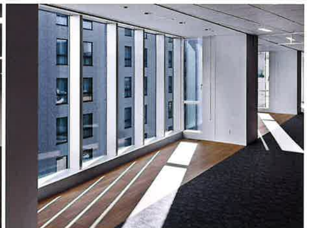
自然換気窓を備えるインナーバルコニー
