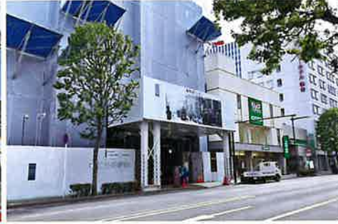
メインゲートに設置した防護構台
