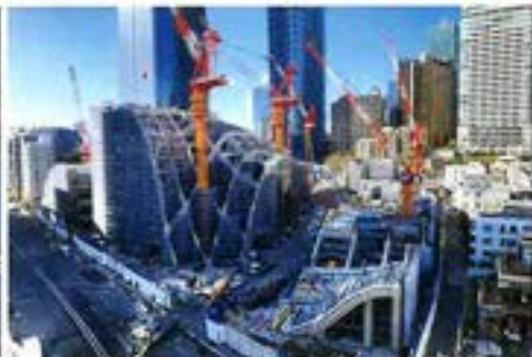
2022年12月の工事状況
