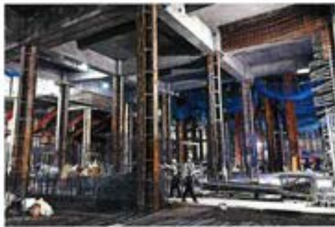
地下外周部掘削逆打ち状況
