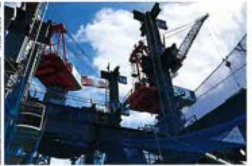
遺上階鉄骨建方状況
