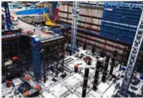
逆打ち鉄骨建方開始状況
