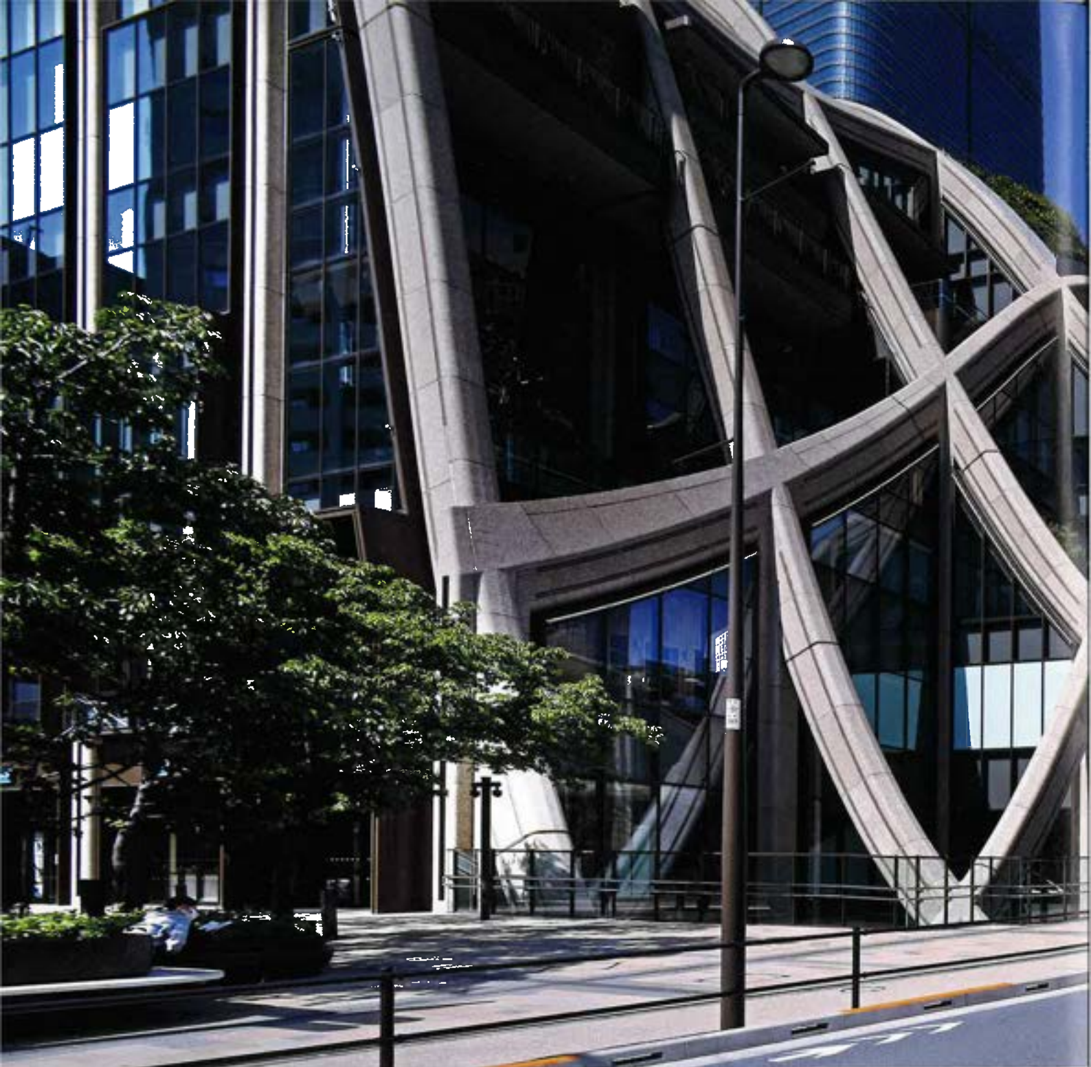
ヘザウィック・スタジオのデザインによるガーデンプラザの外装。ネットフレームと外構、パビリオンが立体的に交差する
