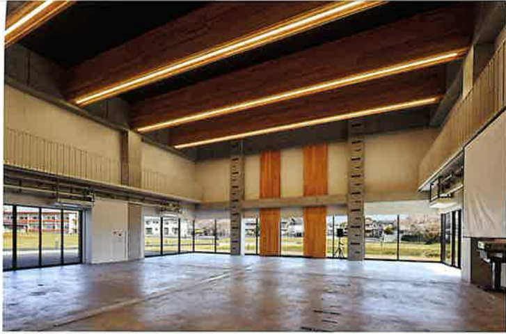
内外一体利用可能な木造木質空間 iArena (大型実験室) CLT耐震壁とRC梁・CLT柱枠のハイブリッド構法「RCLT梁」を採用
