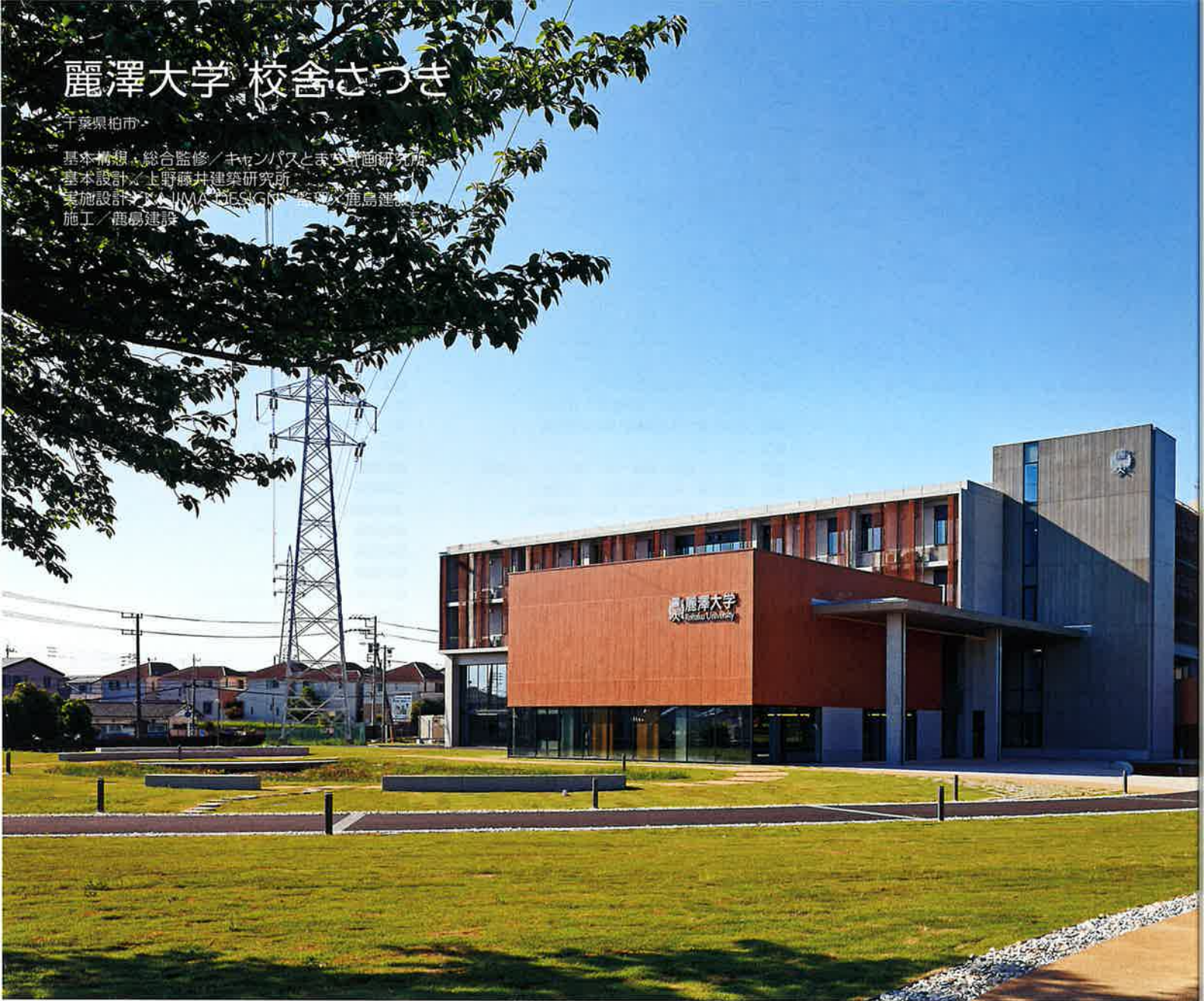
明るく開放的なランドスケープと一体となる校舎さつき 校舎北側のレインガーデンは学生・教員・近隣住民の交流の場となる
