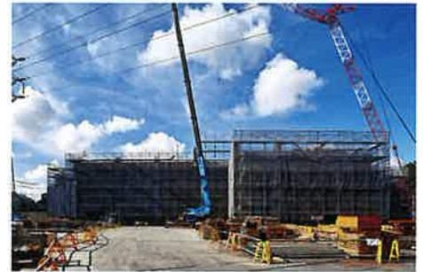
高圧送電線が走るなかでの大型クレーンを用いた施工状況 (写真提供：鹿島建設)
