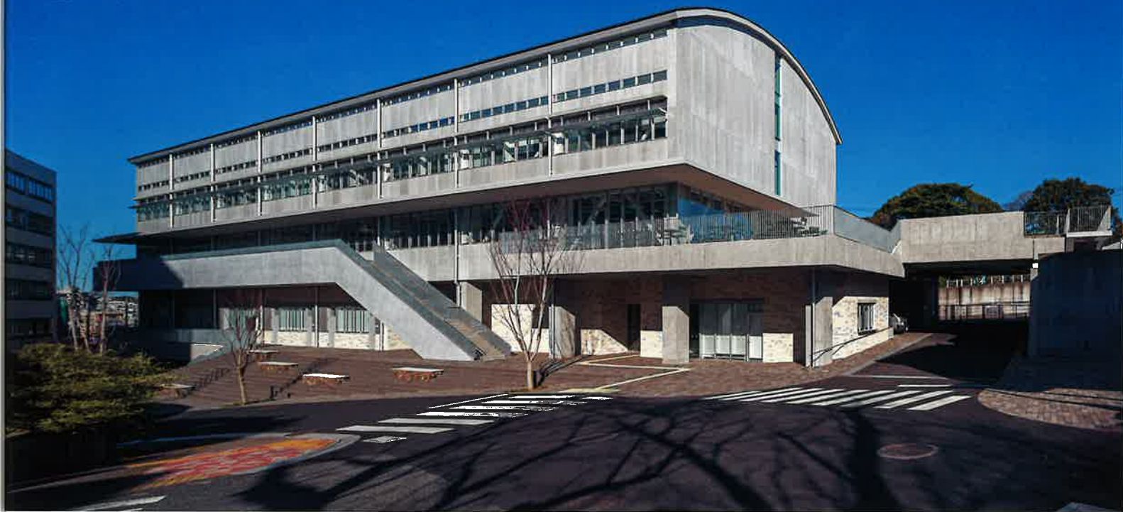
大岡山西5号館 南東側外観
