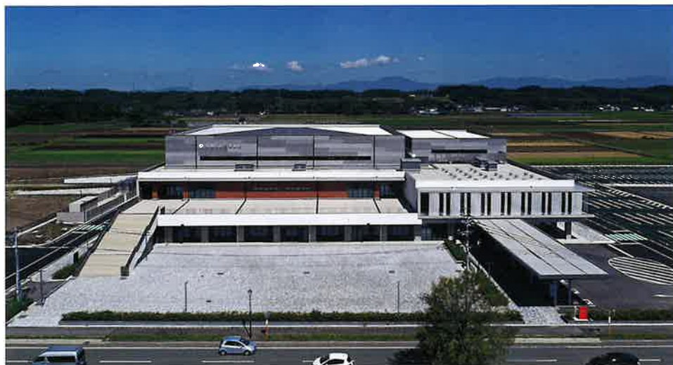
南側鳥瞰 外部から直接出入りができる外階段や大きな屋外テラス
