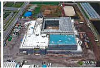
立体トラス施工状況
