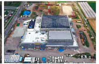
アリーナ屋根施工状況
