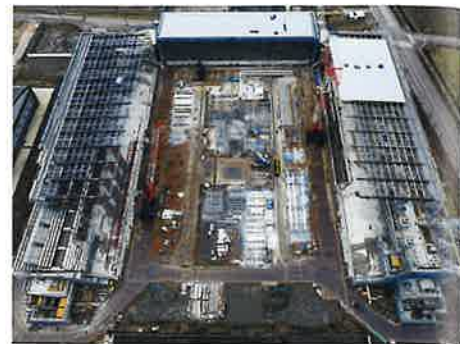
施工状況俯瞰
