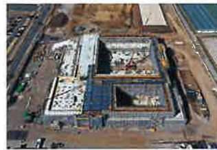
躯体工事施工状況
