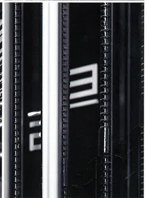
左頁／等辺山形鋼とソリッド照明による吹抜部のレリーフ* 左上／共英製鋼のQRコードを構成する等辺山形鋼 左下／自社の異形棒鋼による階段手摺とQRコード* 右上／打合せコーナーと階段室* 右下／手摺壁継手部と鋼材を用いた階数サイン*
