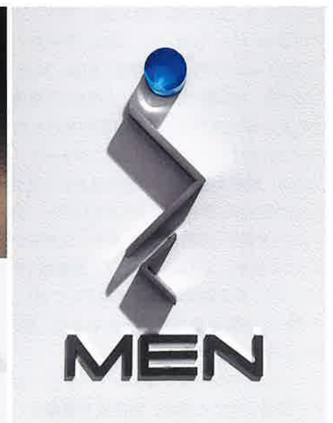
左上/フラットバーの積層による階数表示 左下/異形棒鋼を利用した室名サイン 右/2種類の等辺山形鋼を利用したトイレサイン
