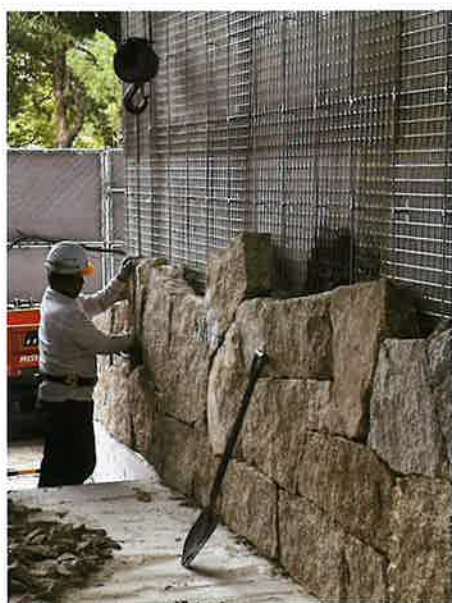
車寄せ軒下の壁に石張りを施工する様子
