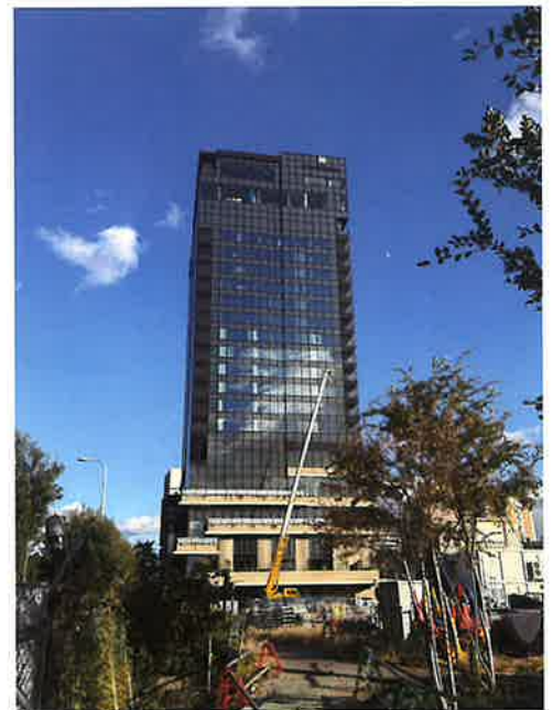
2024年12月時点での建設状況
