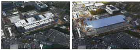
2024年8月施工状況
