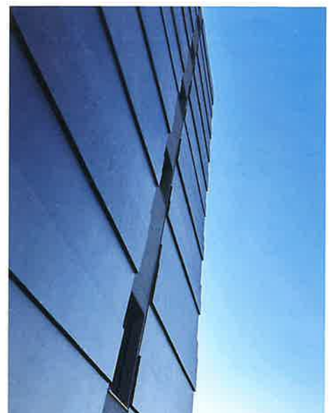
北面外壁は躯体で凹凸を造形したうえ、OSHIROXによる特殊な塗装を施している(写真提供:野生司環境設計)
