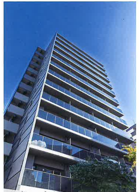
北西側外観見上げ
