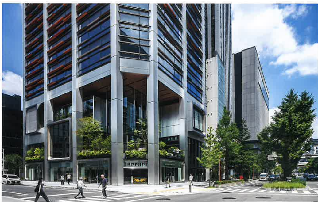
ピーク・年間積算の日射量の両方をチェックしながら、必要な日射遮蔽性能を確保
