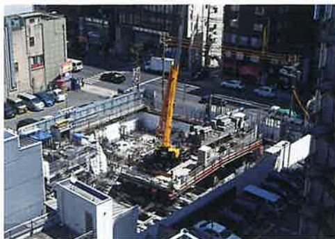
基礎工事状況
