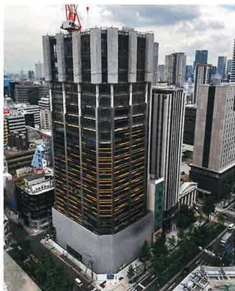
工事状況全景
