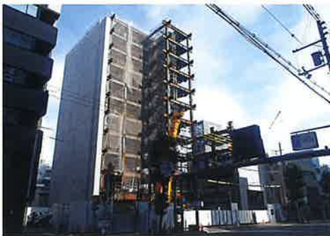
4工区鉄骨建方時状況
