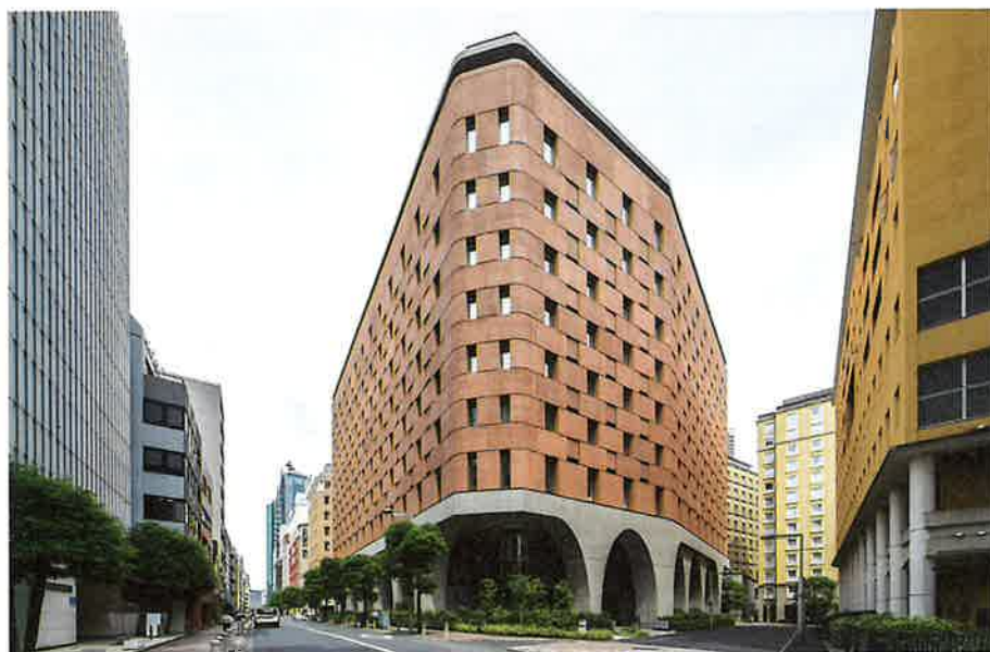
上 千鳥状に積層された構造体PCaブロックによる組織造。PCa版、開口部、自然換気口が統合されたファサードデザイン。PCa版はウォーター ジェット横引仕上げ+ふっ素樹脂塗装 | 中 内観。構造体の厚みが断熱性能を高め、深いダキが日射遮蔽と反射光取得を同時に実現 | 下 外観全景
