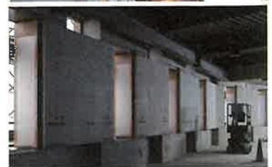
上 工場で仕上げまでを行ったPCa版を積み上げる | 中上 PCa版同士を機械式継ぎ手により接合 | 中下 外殻PCa とロングスパン梁のピン接合部 | 下 施工時の内観。ビジョ ン部と上部自然換気口の開口が見える [上中下・下、撮影：カツタ写真事務所 | 中上、写真提供：竹中工務店]
